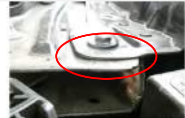
画像⑥左フロントインサイドパネル先端部分 こちらはフェンダーとの合わせ目が歪んでいる
